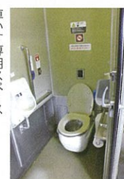
車いす対応トイレ
