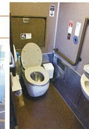
車いす対応トイレ
