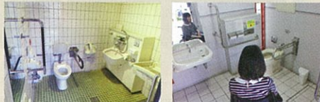
尾道駅多目的トイレ
