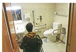
湊泉閣 1階車いす対応トイレ
