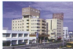
松江アーバンホテル 1号館2号館 松江市朝日町590-3 TEL 0852 (22) 0002
