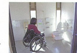
↑ 駐車場多目的トイレ
