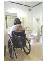
大浴場付近車いす対応トイレ
