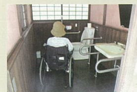
②清水寺前休憩所駐車場
