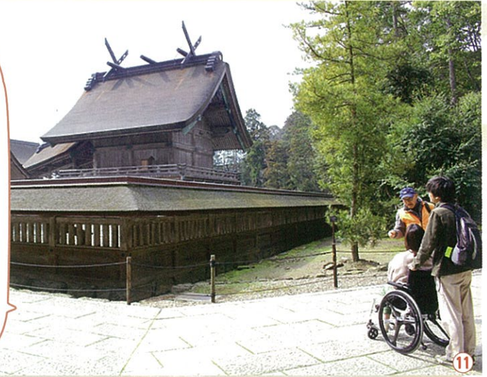
御本殿の周りを一周でき間近に見ることができる
