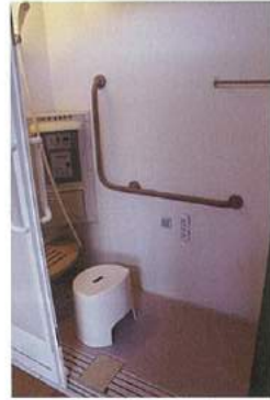
サンタリー棟にある車いす対応シャワールームは段差なしで利用可能 (1回 200円)。
