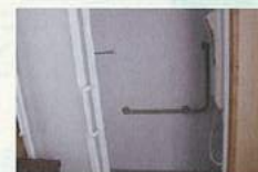
車いす対応 シャワールーム
