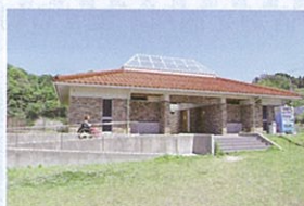
シャワー・トイレ入口にスロープあり。
