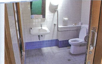
車いす対応トイレ（男子）
