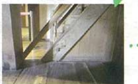
敵が登りにくいよう、傾斜角約45度の急な階段。
