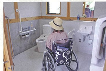
車いす対応多目的トイレ新設
