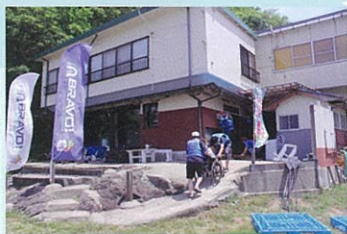
更衣室・シャワールームへのスロープ
