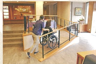
1階に新設したエレベータへのスロープ
