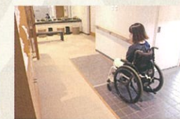
入口のスロープ
