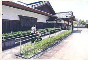
入口のスロープ
