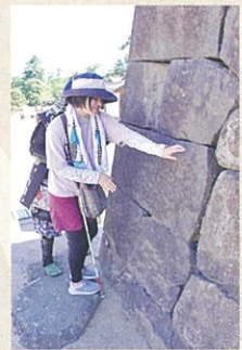
石垣の角は大きな石で補強してある!
