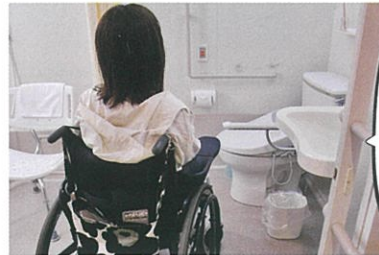
段差の無いユニットバス
