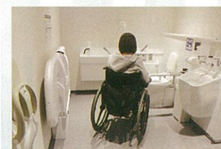
1階のオストメイト対応多目的トイレ
