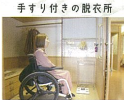
手すり付きの脱衣所
