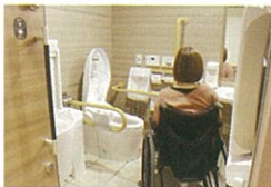
1階オストメイト対応多目的トイレ
