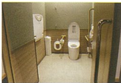
2階車いす対応多目的トイレ
