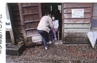
出入口に段差あり
